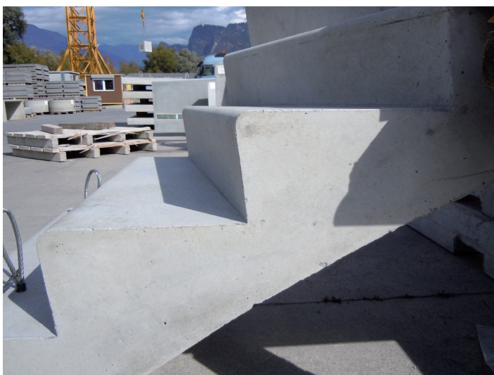
Treppenausbildung: Die Treppenoberflächen sind Lunken frei, die Kanten sind gerundet
