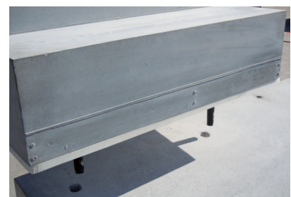
Sicherungsstift mit Mantel, Hülse eingelegt
