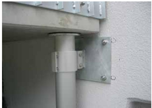
Stützenfixation an der Fassade
