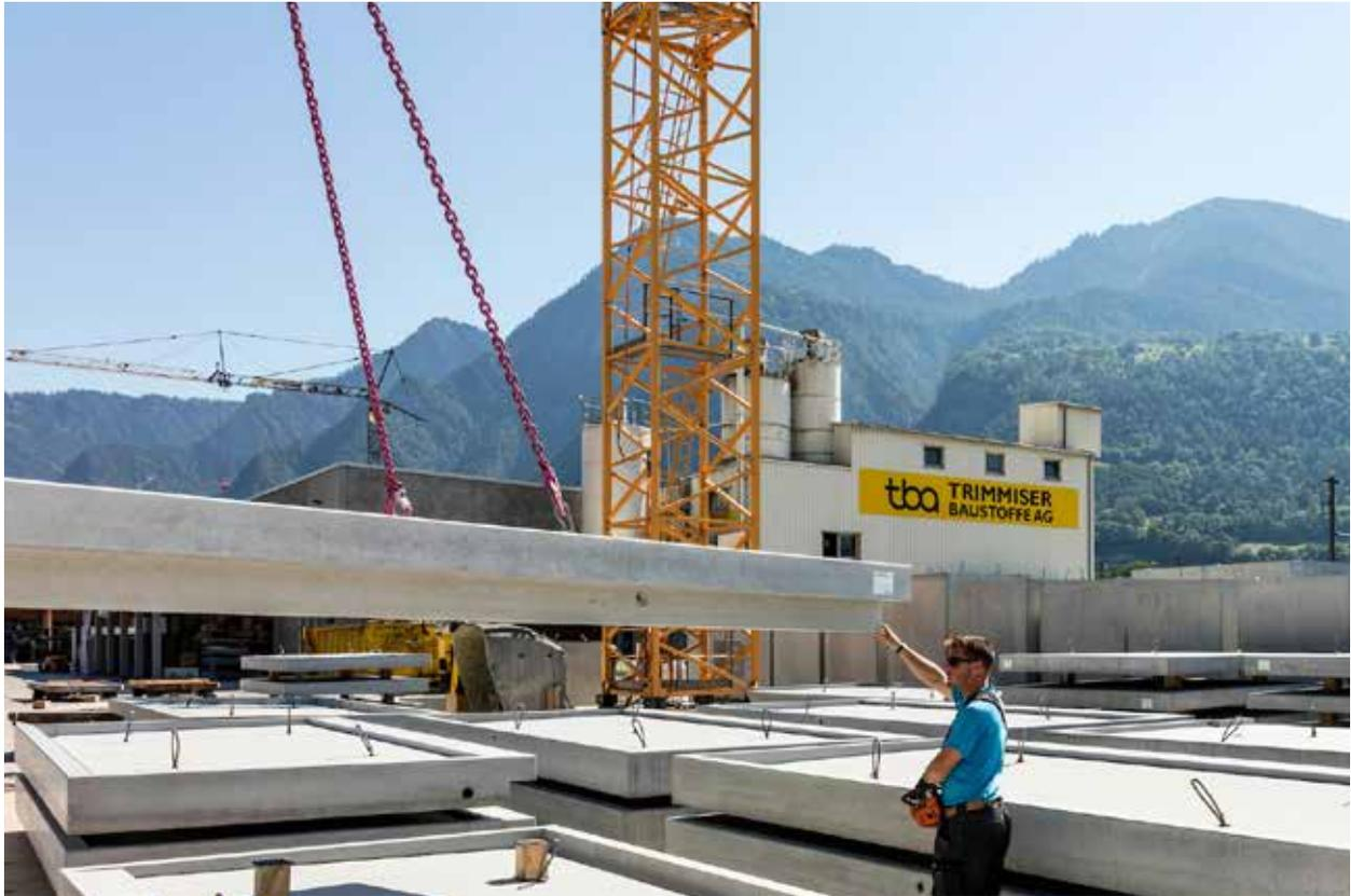
Die **Montage** erfolgt in kürzester Zeit. Wir haben im Werk die notwendigen Lagerflächen und führen die Elemente «just in time» der Einbaustelle zu. Der Stahlbauer oder der Bauunternehmer übernimmt das Versetzen. Wir planen die notwendigen Einlagen.
