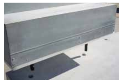
Sicherungsstift mit Mantel, Hülse eingelegt
