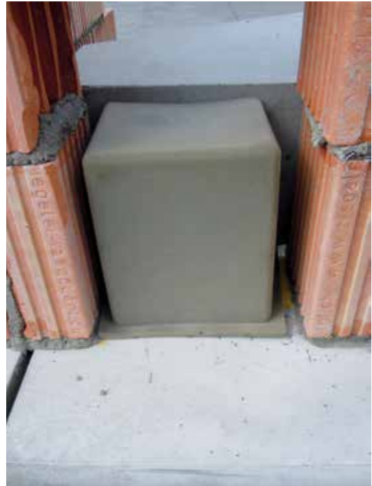
Schallschutzbox: Optional kann eine Schaumstoffbox zur Vermeidung einer Schallbrücke mitgeliefert werden.
