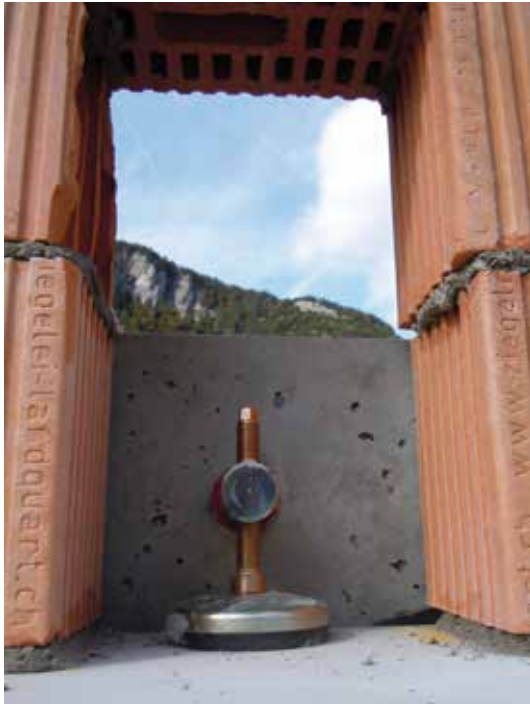
Treppenlager: Kein überstehendes Lager während dem Einbau. Einfaches Justieren beim Montieren.
